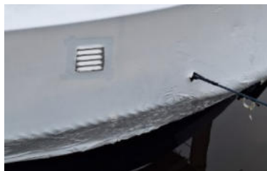
Ventilatioerooster en doorvoer landvast.
