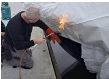
De folie wordt over de band omhoog geklapt en vast gesmolten.
