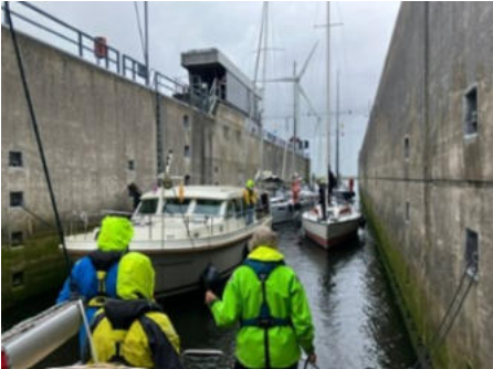
Even proppen in de Volkeraksluizen
